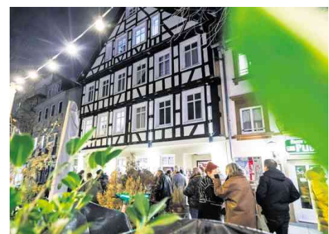
Das frühere Restaurant Drei Mohren ist saniert und als Cafébar Juwel neu eröffnet – noch ohne Figuren.
